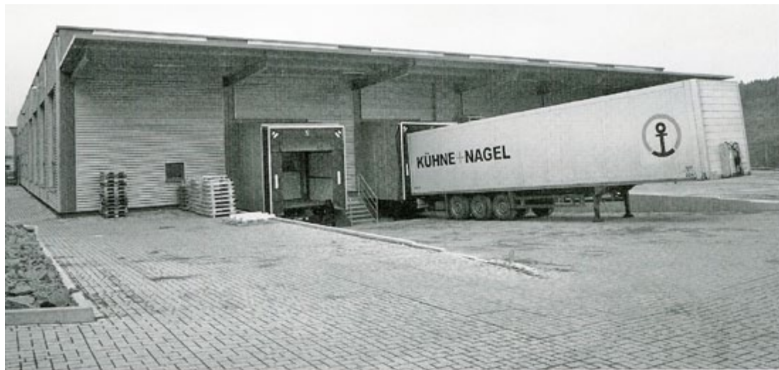
Durch die dritte Erweiterung von Stumpf Metall im Industriegebiet Lehnscheid stehen weitere 1.000 qm umbaute Fläche und weitere 1.000 qm Außenfläche für die Verlade- und Versandaktivitäten zur Verfügung.
